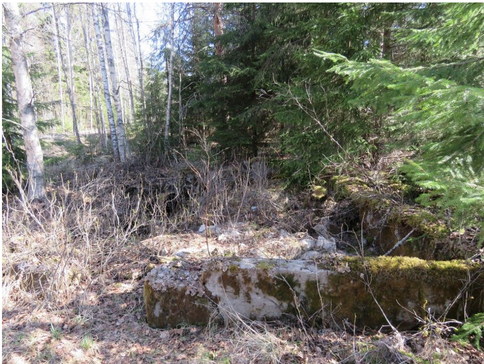
Kuva 15 a. Isosaareen johtavan tien varrella oleva suurin rakennuksen perustus kuvattuna koilliseen.
